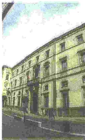
IL BO L'ingresso del palazzo
